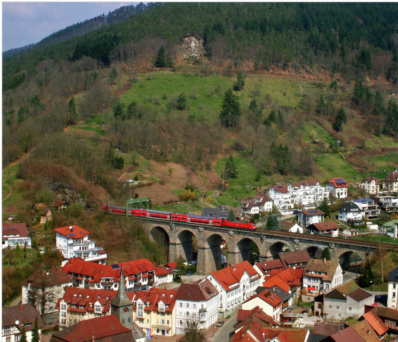
▲ Видук Хорнберг Шварцвальдской железной дороги поистине уникален. Семь его арок перекрывают расстояние в 150 м.
